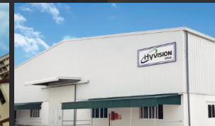
베트남 공장 (10,480m 2 , 약 3,234평)
